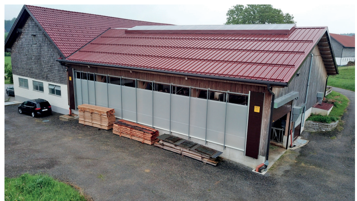
FÜR OPTIMALES STALLKLIMA und Beschattung sorgen an den Längsseiten Agrotel-Curtains, die unterschiedlichst geöffnet werden können.
