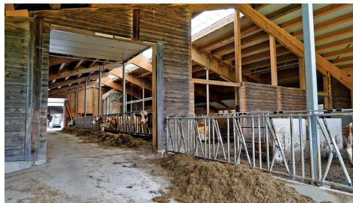
ALT UND NEU: Die Stallerweiterung ermöglicht mehr Spielraum bei den Liegeplätzen und wertet den Altbestand hinsichtlich Licht und Luft enorm auf.
