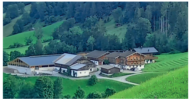
VOM AUSHUB BIS ZUR FERTIGSTELLUNG: Die Umbaumaßnahmen konnten innerhalb von fünf Monaten umgesetzt werden. Das ist sowohl der guten Zusammenarbeit mit den Baufirmen als auch der hohen Eigenleistung zu verdanken.
