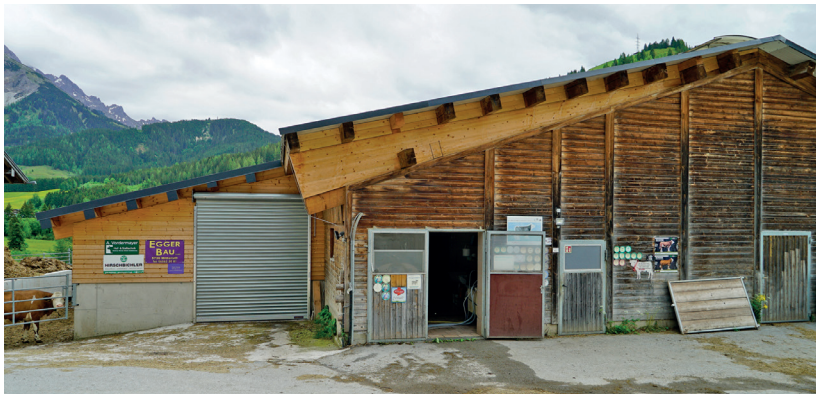
DER ANBAU FÜR DIE KÄLBER (links) erforderte eine Anpassung des Dachstuhls. Mit einem Leimbinderkeil konnte die Dachneigung vermindert und die entsprechende Raumhöhe erreicht werden.
